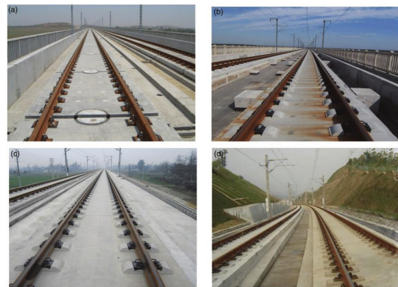
รูปที่ 1 โครงสร้างทางรถไฟรูปแบบต่าง ๆ (a) CRTS I , (b) CRTS II , (c) CRTS III , (d) CRTS Double-Block (DB) (Wang et al. (2020))
